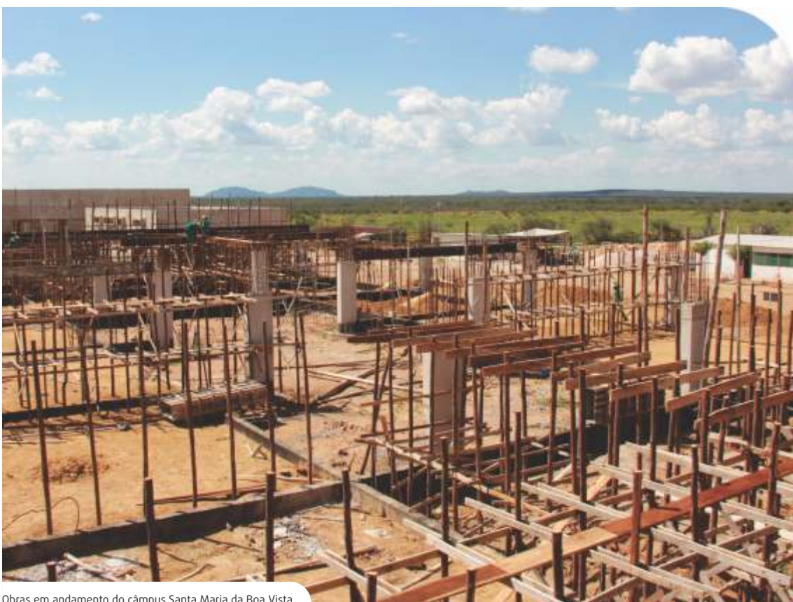
Obras em andamento do câmpus Santa Maria da Boa Vista
