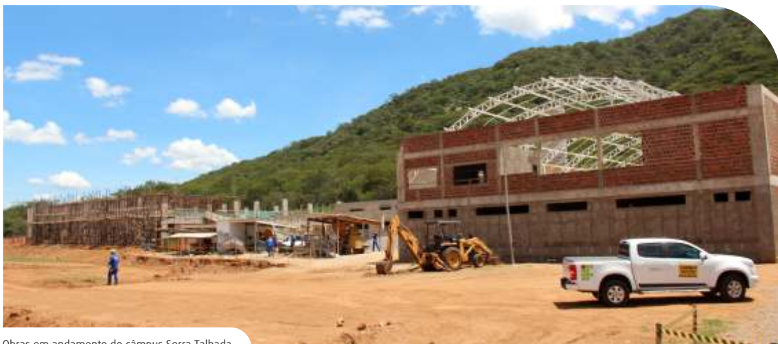
Obras em andamento do câmpus Serra Talhada
