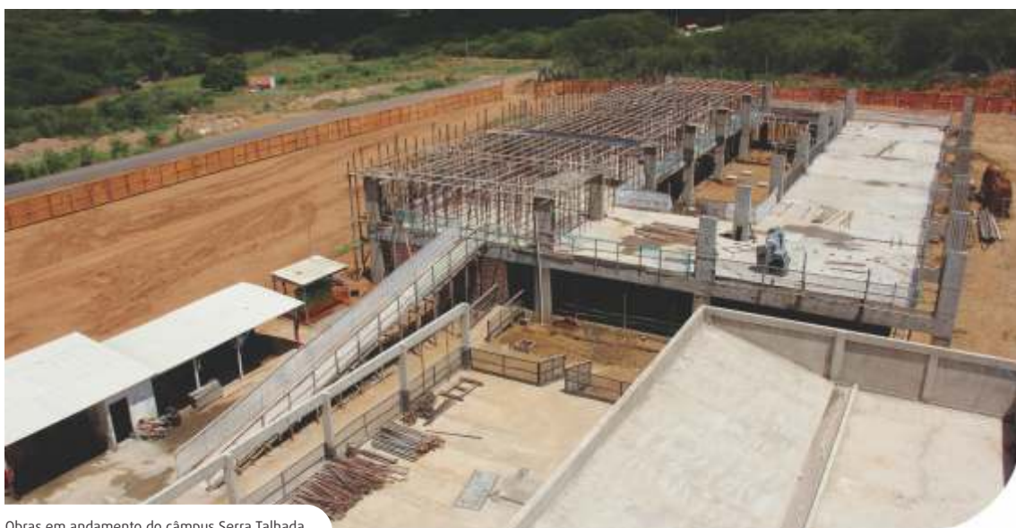
Obras em andamento do câmpus Serra Talhada
