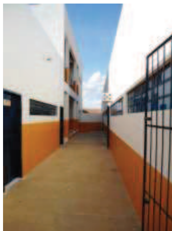
Vista geral do segundo corredor lateral
