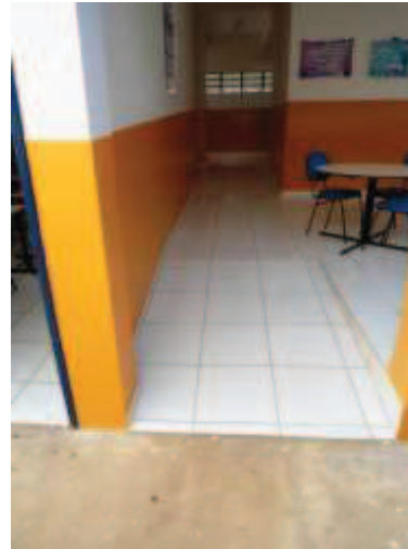
Rampa de acesso ao térreo pelo segundo corredor lateral
