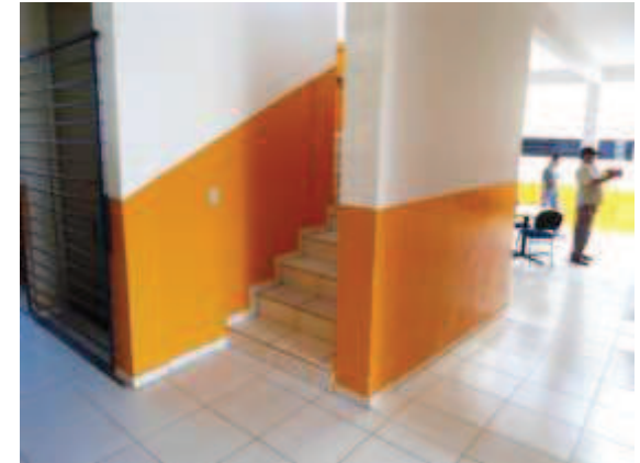
Rampa de acesso, escada e poço de elevador (acesso ao pavimento superior)
