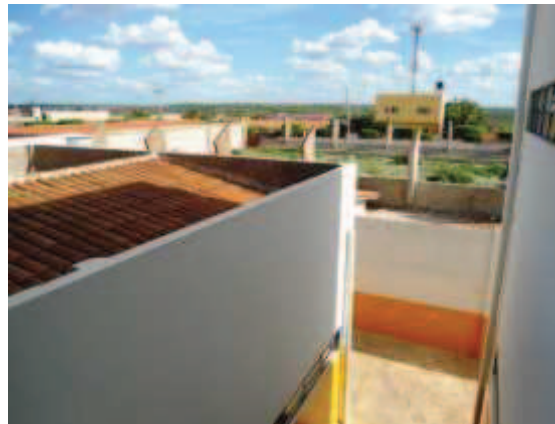
Vista geral da quadra poliesportiva inacabada (a ser anexada), a partir do pavimento superior
