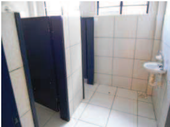
Banheiro feminino do térreo
