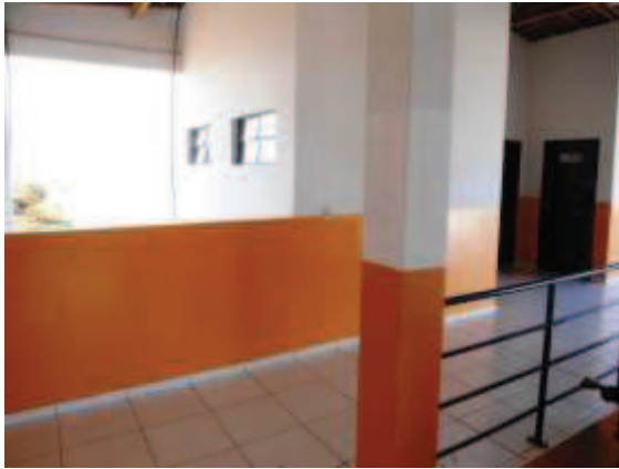
Vista lateral a partir da saída da escada, no pavimento superior
