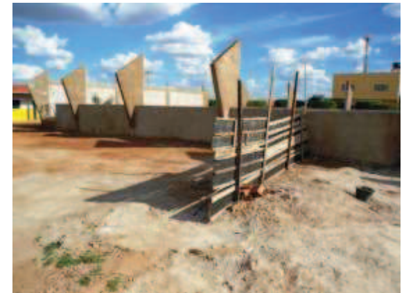
Quadra poliesportiva inacabada (a ser anexada ao prédio escolar)
